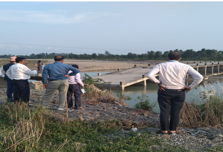
बाढीबाट क्षतिग्रस्त कजवेको अनुगमनको क्रममा
